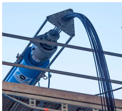
Kernstück des Verschubs: Sogenannte Litzenheber, die mit Hydraulikhilfe die Brücke schubweise ziehen.
